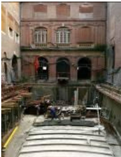
Travaux dans la cour d'Honneur du mTL © Dominique Delpoux.
